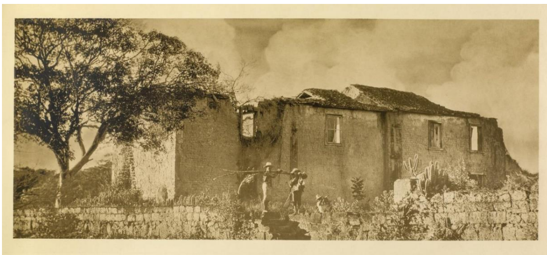
Ruínas da Capela de Santo Antônio dos Militares, 31 de maio de 1931. Nada sobrou além dos alicerces de pedra. Foto: Benjamin Rondon/Arquivo Nacional.
