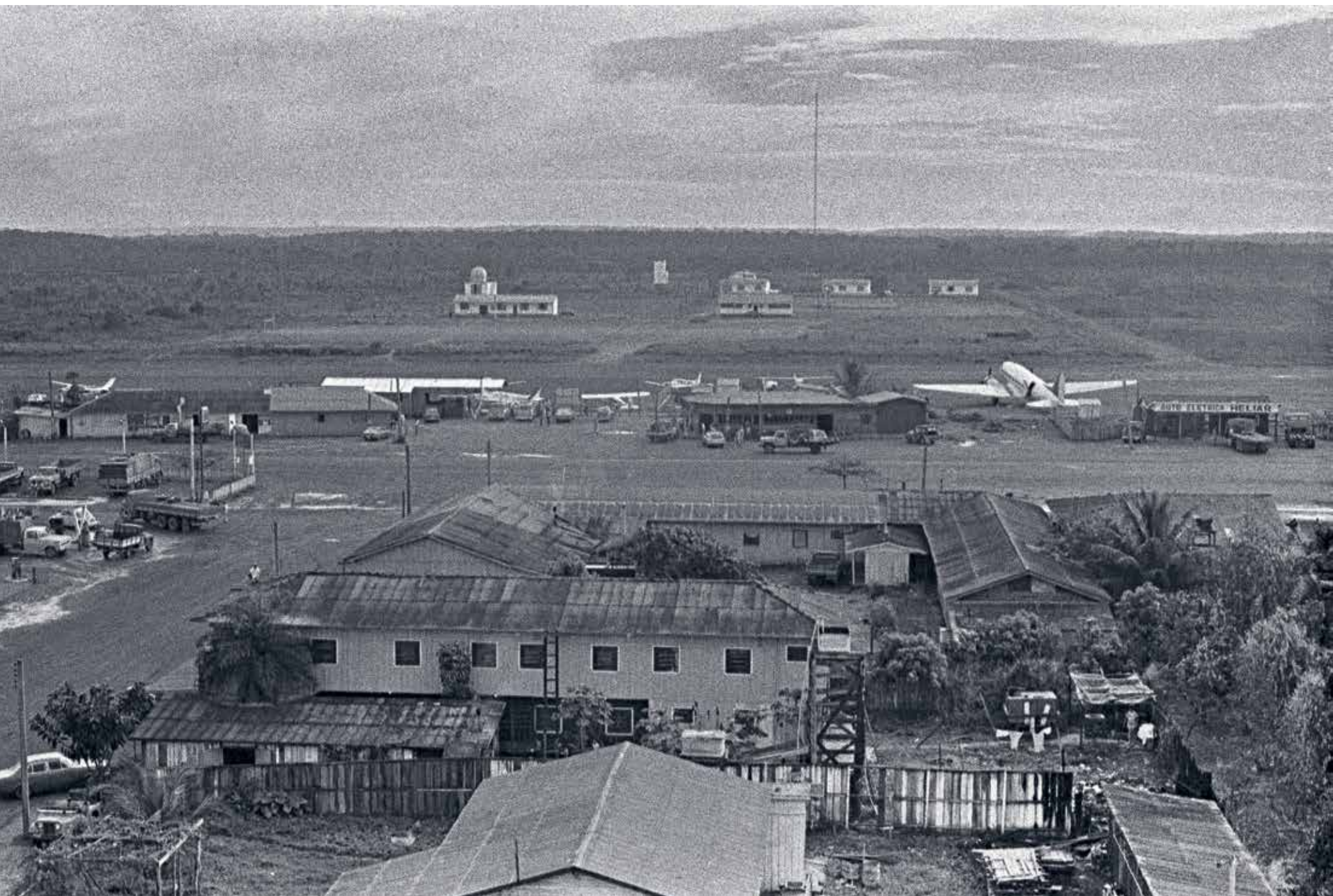
VILHENA, 1978 – O CAMPO DE POUSO ONDE HOJE É O CENTRO DA CIDADE, VISTO DO ALTO DA CAIXA-D'ÁGUA DA PRAÇA PADRE ÂNGELO SPADARI
